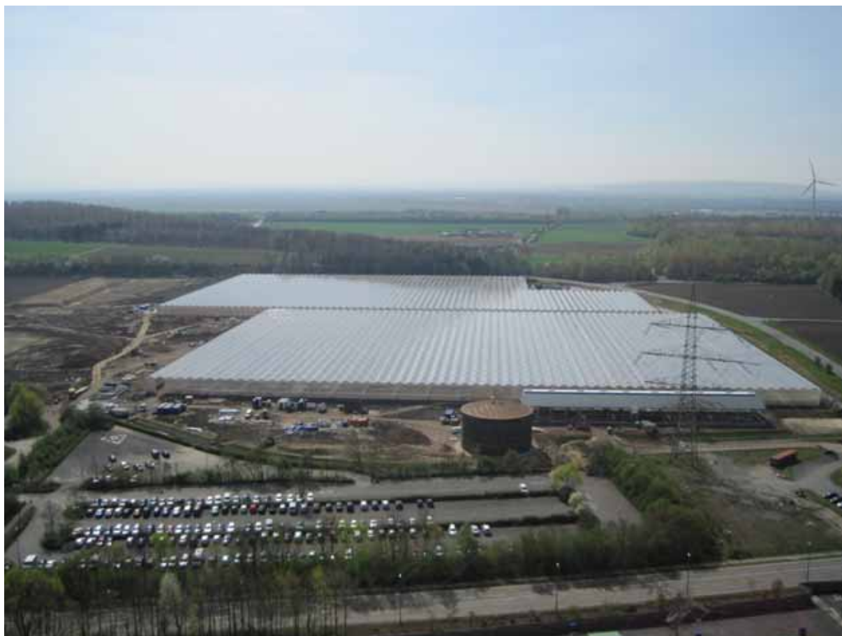
Erster Bauabschnitt des Gewächshausparks Neurath
