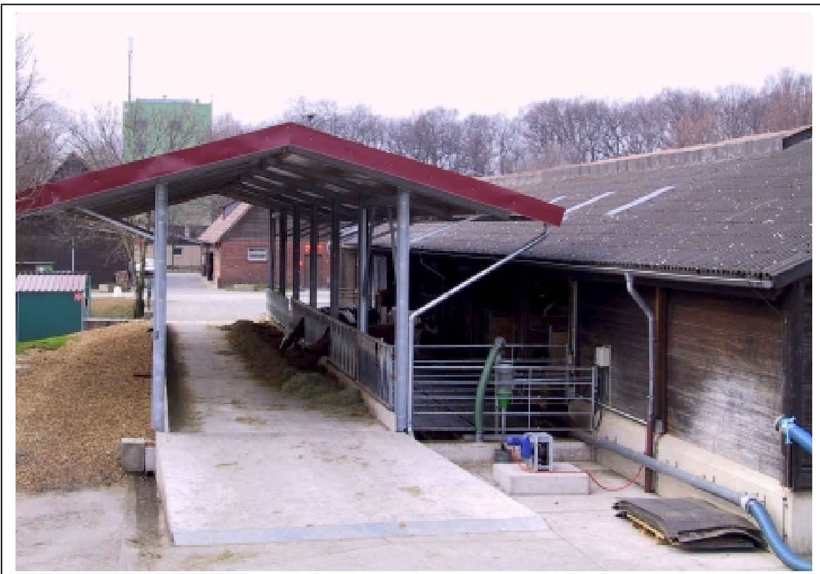
Bild 1: Ostansicht des umgebauten Stalles
