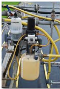
Wenn der Behälter dicht ist, ist kein Druckausgleich vorhanden
