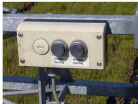
Fernbedienung (intakte Kabelführung etc.)
