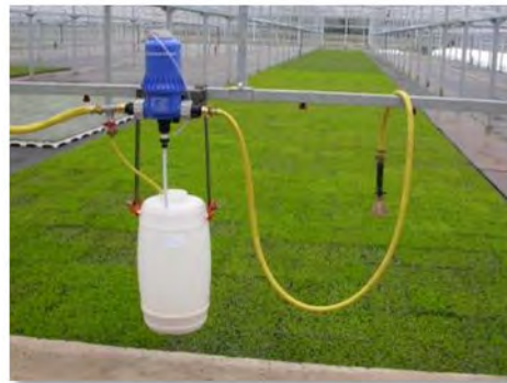
Ablassvorrichtung fehlt komplett
