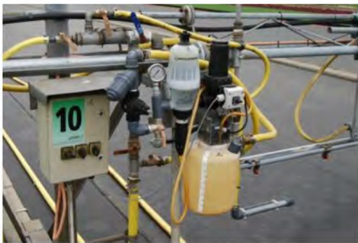
Evtl. mit geringem Mangel (trüber Behälter)
