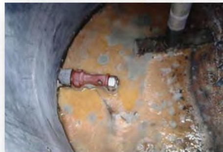
Rührwerk zu hoch positioniert
