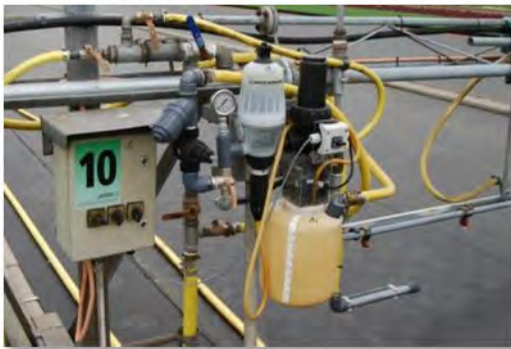
Ablassvorrichtung fehlt komplett
