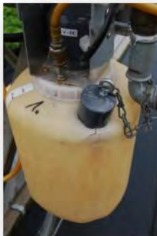
Behälter am Deckel gerissen
