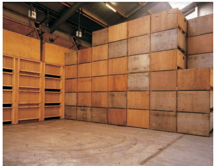
Abbildung 1: Die Kistenzwangsbelüftung, bestehend aus einer Belüftungswand und geschlossenen Großkisten, stellt ein sehr effektives Belüftungssystem dar
