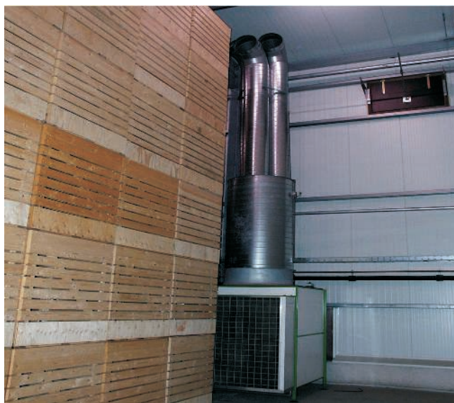
Abbildung 2: Bei der Kistenraumbelüftung umströmt die eingblasene Luft die offenen Großkisten
