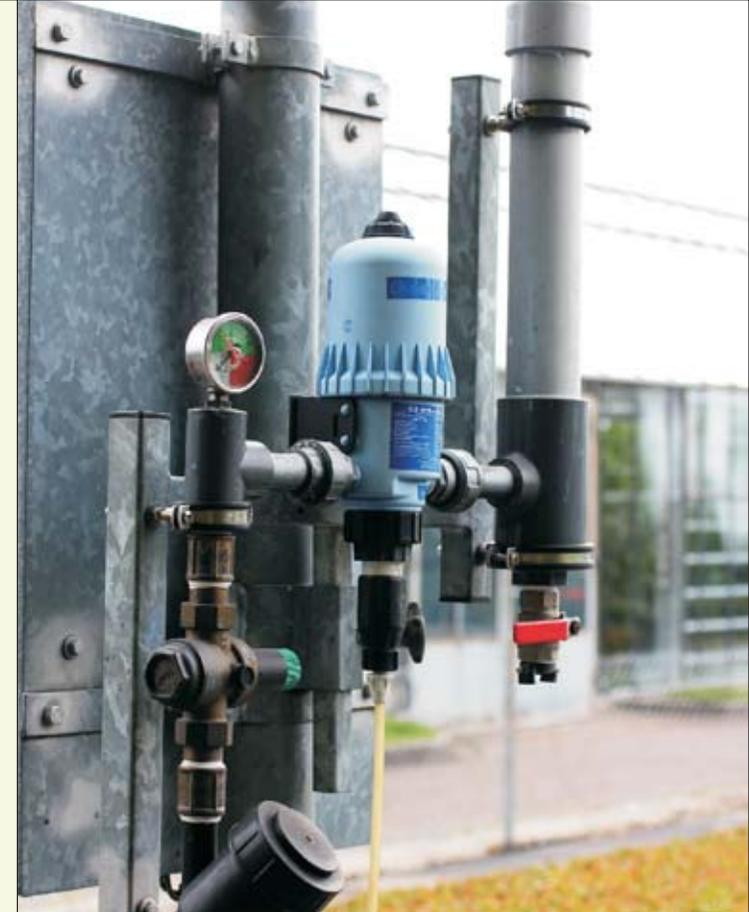
mengenproportionale Dosierung (Filter/Druckminderer/Manometer/Dosiereinrichtung/Mischkammer)
