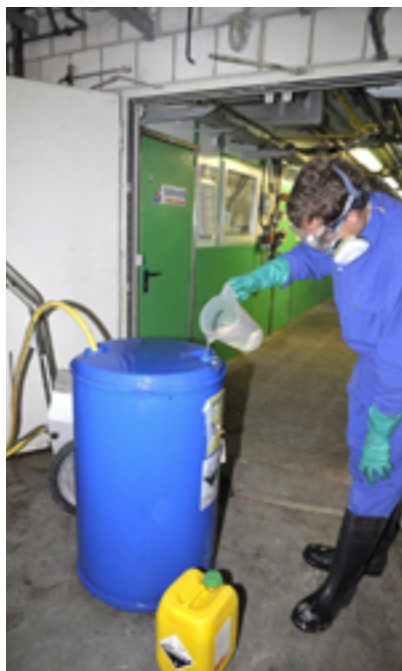
Oft macht es Sinn, die Desinfektionslösung zunächst in einem Vorratstank anzusetzen.
