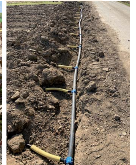
(3): Tropfschlauch Unterflur
