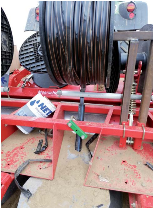
Abb. 4: Verlegen der Tropfschläuche mittels Dammfräse
