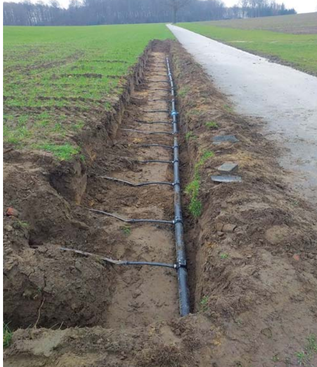
Abb. 2: Kopfleitung mit Abgängen nach Einbau im März 2023
