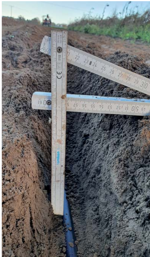
Abb. 1: Verlegungstiefe der Tropfschläuche
