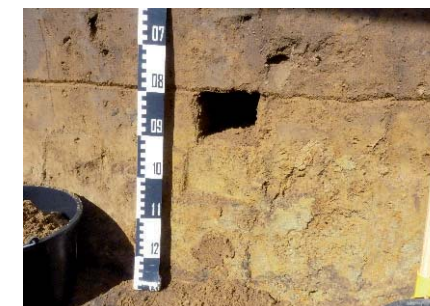
Seitenstrang für Saugplatteneinbau
