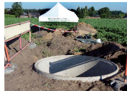
Saugplatten und Sammelschachteinbau
