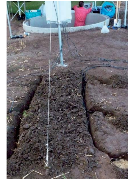
Tensiometer im Boden verbunden mit Wetterstation im Hintergrund Sammelstation des Sickerwassers
