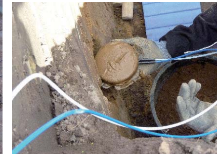
Saugplatte eingeschlämmt kurz vor Einbau
