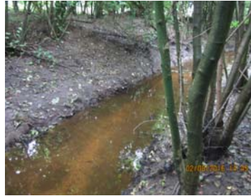
Abb. 92: Brooksbach im Bereich Klyer Damm, Hochmoor
