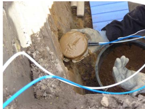
Abb. 169: Eingeschlammte Saugplatte vor Einbau in den Boden
