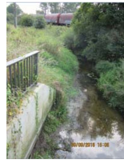
Abb. 111: Bahnlinie über dem Flaggenbach bei Rinke- rode
