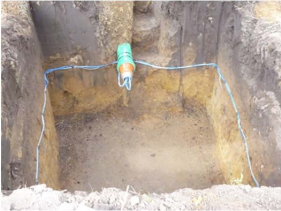
Schläuche und KG-Verbindungsrohr zur Sammelstelle sind noch sichtbar
