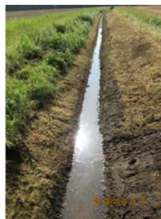
Abb. 115: Flaggenbach nach der Grabenräumung
