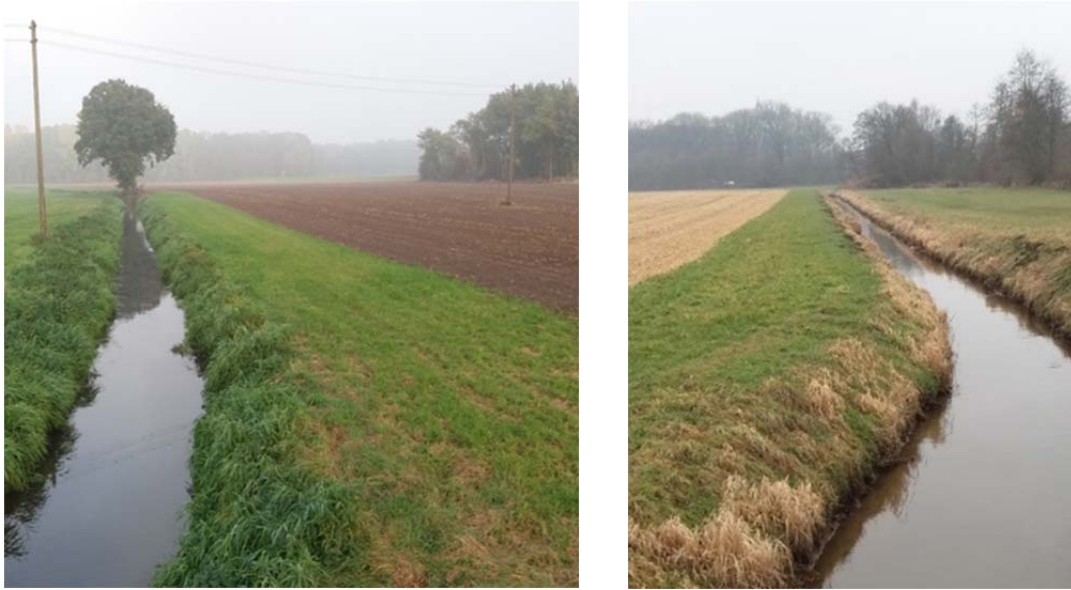
Abb. 42: Beispiele für neu angelegte Gewässerrandstreifen an der Gochfortsley (23.10.2016)
