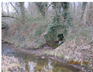
Abb. 66: Einleitungsstelle des Grabens hinter der Ferienhausanlage in den Thesingbach
