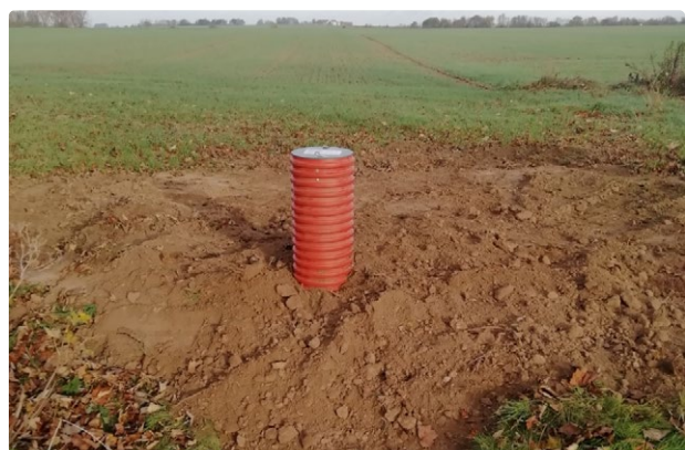
Abb. 10: Drainageregulierung mittels EkoDrena
