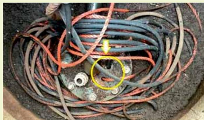
*Brunnenkopf mit undichter Seil- und Kabeldurchführung*
