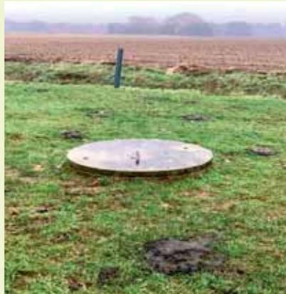
*Mangelhaft geschützter Schachtbrunnen (undichte Abdeckung, fehlende Schutzzone)*
