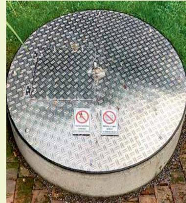
*Mögliche Lösung zur Abdeckung eines Schachtbrunnens*
