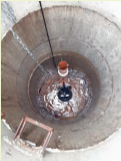
Abb. 2: „Uhling Drain-Control“ mit teleskopierbarem Rohr
