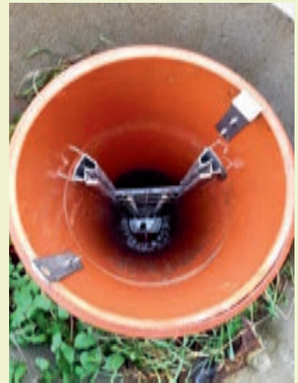
Abb. 1: „EkoDrena“-Schacht mit Schiene und Anstauklappen in der Mitte (Draufsicht)
