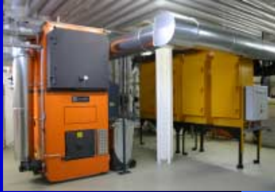
wassergekühlte Vorschubrostfeuerung mit Rauchgasrezirkulation + Filter
