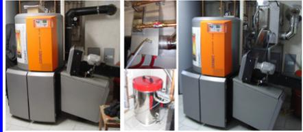
Abbildung xx: Abscheideeinrichtung der Firma Schröder (hydroboil) am Powercorn 7-30
