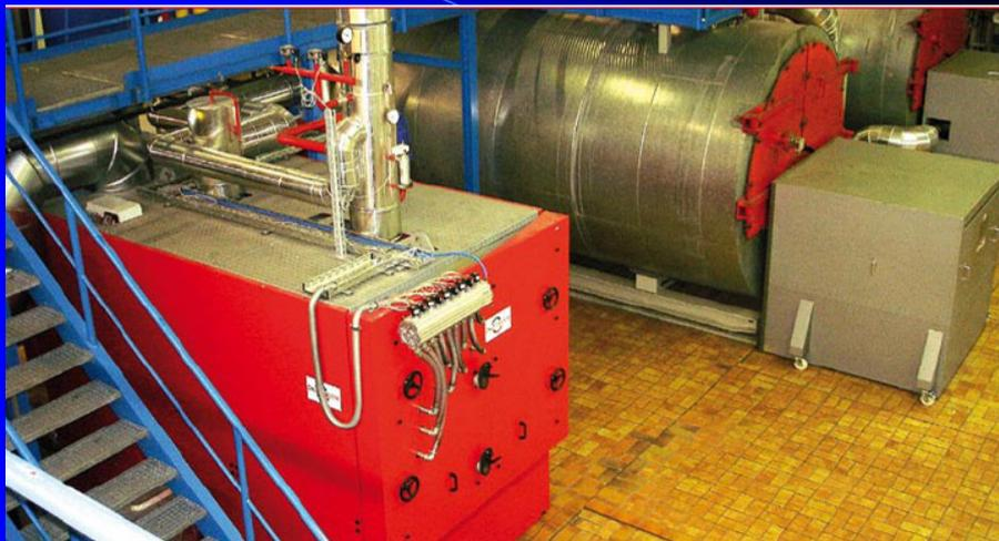
Die ÖKOTHERM®-Biomasse Heizanlage mit 600 kW als Grundlastkessel in Kaskade mit zwei Gaskessel und BHKW
