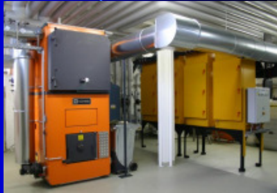
wassergekühlte Vorschubrostfeuerung mit Rauchgasrezirkulation
