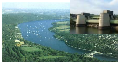
Baldeney-Stausee (9.800 kW, 27 Mio. kWh/a)
