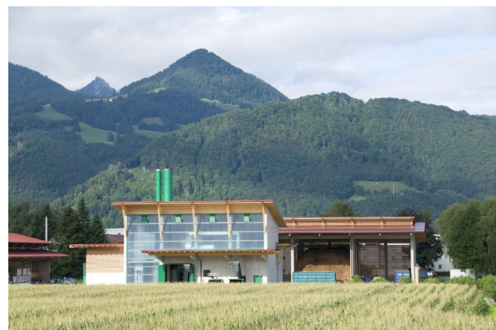
Ansicht Biomasseheizwerk Quelle: Biomassehof Achantal, Auskunft Herr Wimmer
