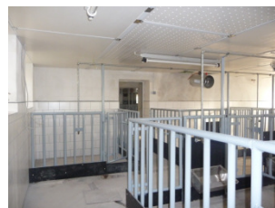
Renovierung Quarantäne Wust
