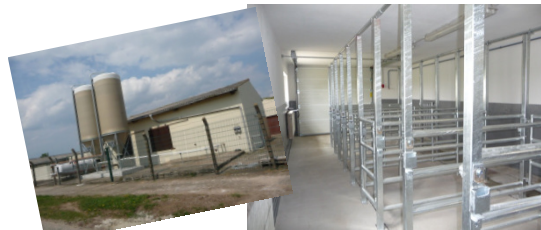
Fischbeck: Neue Silos, neue Ebereinschleuse
