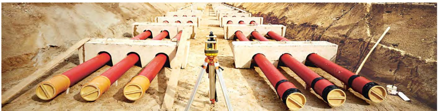
Auch Leitungstrassen können die Agrarstruktur beeinträchtigen. Dieses Bild zeigt die Verlegung von Erdkabeln zum Ausbau des Hochspannungsnetzes.
