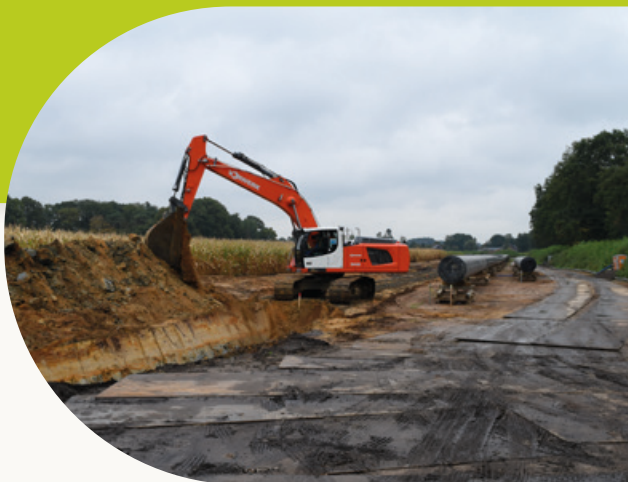
Über Erdarbeiten ist eine Verschleppung von Erdmandeln sehr leicht möglich.
