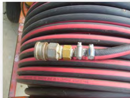
Schlauschellen bei Hochdruckschläuchen geht nicht ( \Rightarrow müssen verpresst werden)
