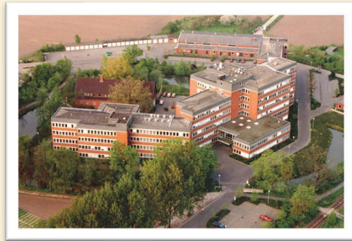
Hauptgebäude Nevinghoff 40, 48147 Münster.
