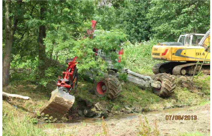
**Flächenschonendes Entfernen von Uferverbau mittels Einsatz eines Schreitbaggers**
