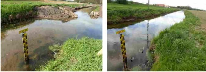
**Pegellatten „vor“ und „hinter“ der Maßnahme zur Kontrolle des ordnungsgemäßen Wasserabflusses**
