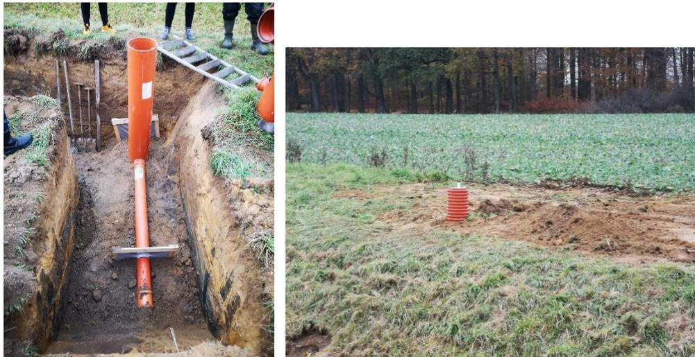
Abb. 5: Einbau der Drainageregulierung in Münster-Kinderhaus (Quelle: J. Molde LWK)
