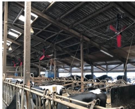
Neue Axialventilatoren im Versuchsstall R1
