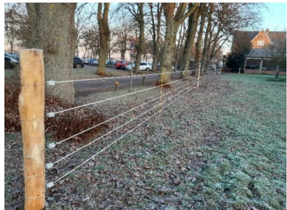
Bei dem neuen Zaun wurden auf allen Abschnitten 5 Litzen bzw. Drähte verbaut. Die unterste Litze hat eine Höhe von 20 cm und die oberste von 120 cm. Damit entspricht die Anlage den aktuellen Empfehlungen für herdenschutzkonforme Festzäune bzw. überschreitet diese in der Höhe. Es ist geplant, die Zaunbauarbeiten auf der anderen Seite des Obsthofes im Januar 2023 fortzusetzen.
