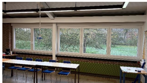
Die neuen Fenster der drei Klassenräume
