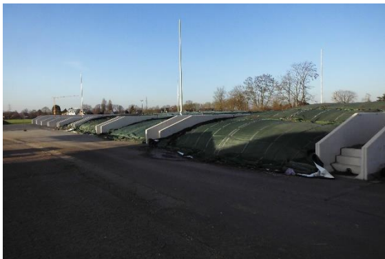
Neu errichtete und bereits befüllte Silokammern, Stand: Dezember 2025
